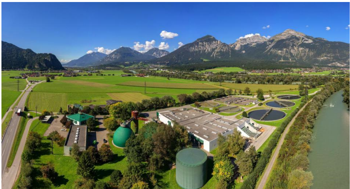
Hình 3. Nhà máy xử lý nước thải Strass, Áo
