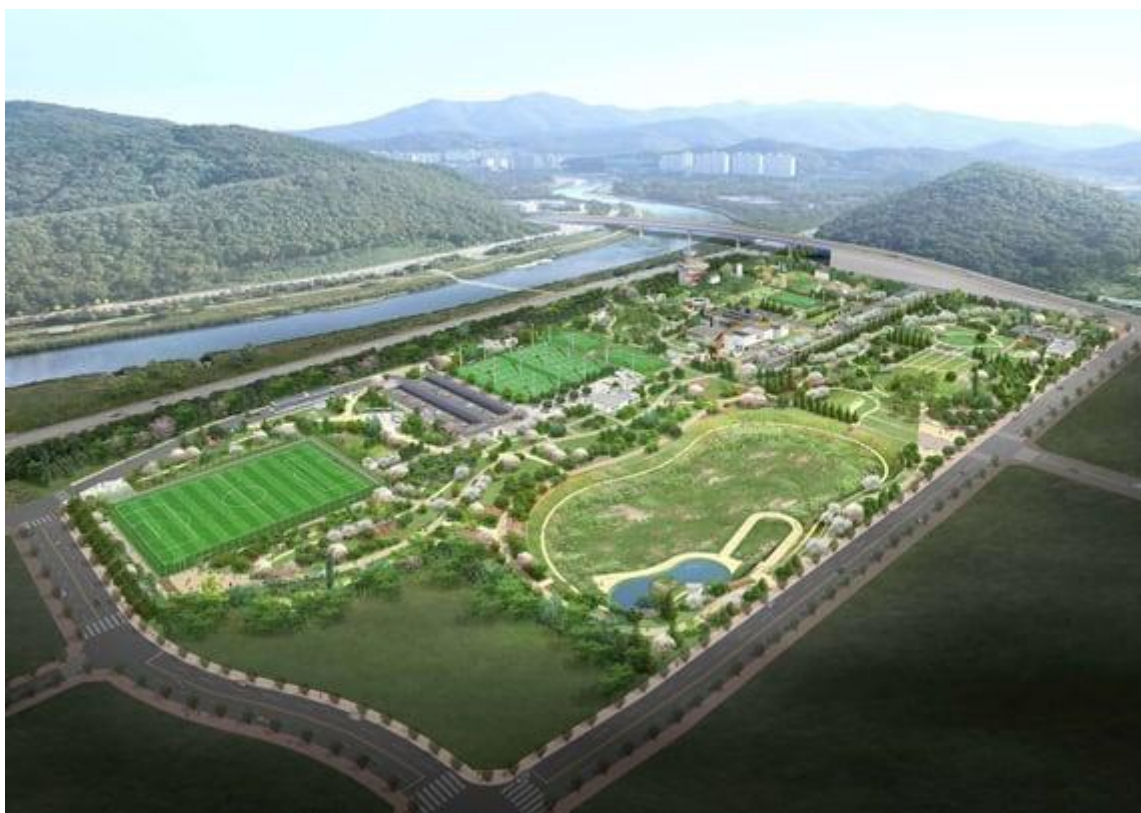
Hình 1. Nhà máy xử lý nước thải Bakdal, Hàn Quốc
