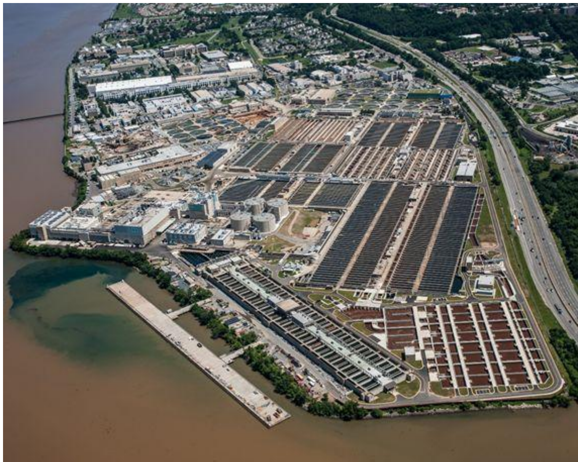
Hình 2. Nhà máy xử lý nước thải Blue Plains, Mỹ
